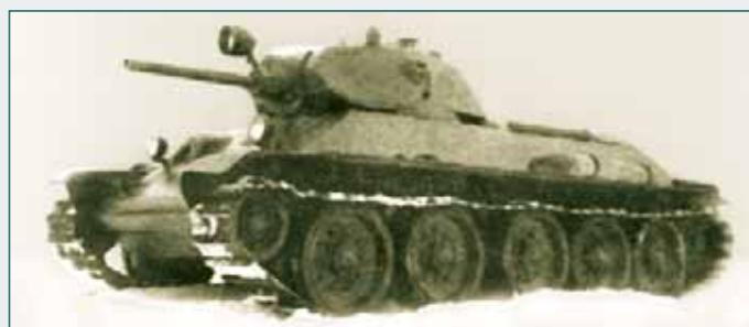
Опытный образец среднего танка А-34 во время испытаний на полигоне НИИТ в Кубинке. Март 1940 года
