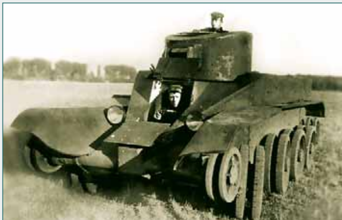
BT-2-ИС. В целях повышения живучести и проходимости машины на пересеченной местности по заданию командующего войсками УВО И.Э. Якира группой энтузиастов, возглавляемой рационализатором Н.Ф. Цыгановым, весной 1934 г. были начаты работы по созданию колесно-гусеничного танка BT-2-ИС.
