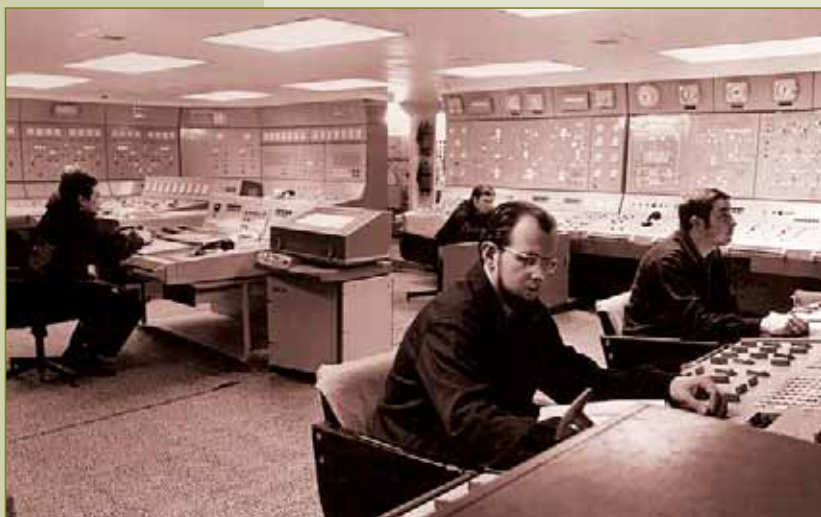
Центральный пост управления энергетической установкой атомного ледокола "Арктика"
