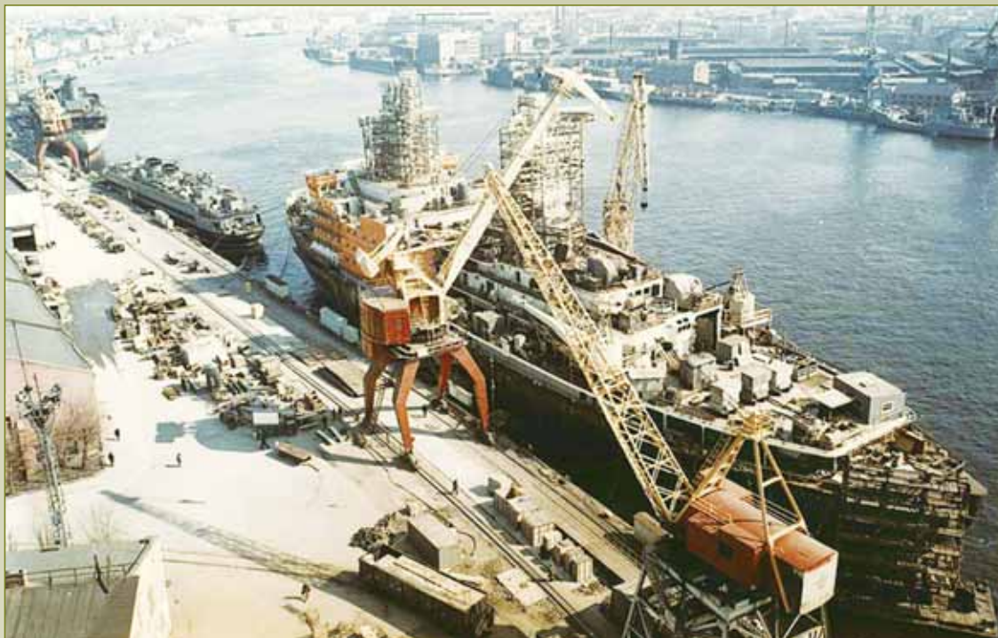
Достройка ледокола "Арктика" у стенки Балтийского завода
