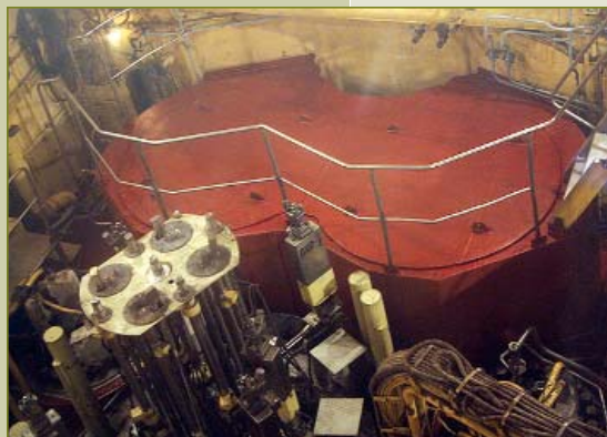
Реакторный отсек ледокола "Ленин"
