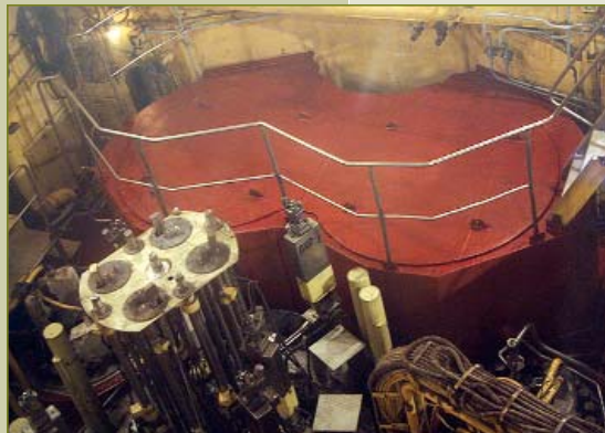
Реакторный отсек ледокола "Ленин"
