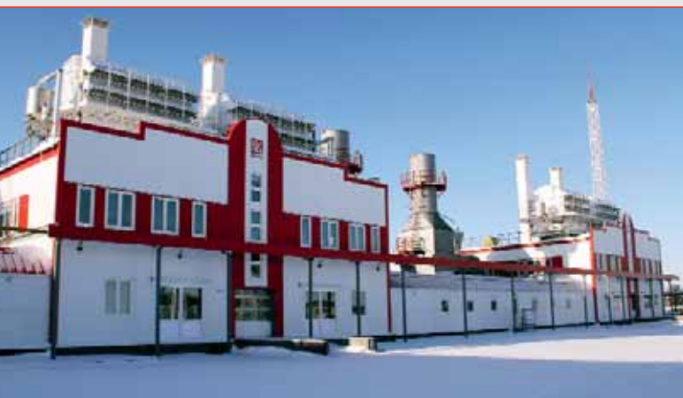
Повховская ГТЭС-48 на базе пермских газовых турбин. ООО "ЛУКОЙЛ-Западная Сибирь"
