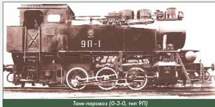
Танк-паровоз (0-3-0, тип 9П)
