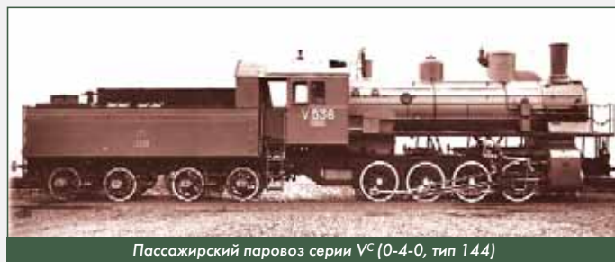
Пассажирский паровоз серии V С (0-4-0, тип 144)
