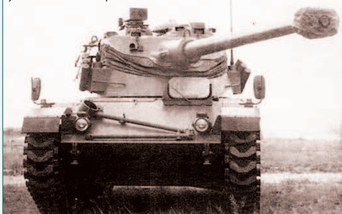
Экспериментальный SK-105. Вместо инфракрасных прожектора и прицела установлена телекамера
