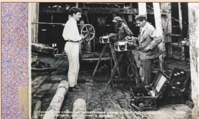
Рис. 7. "Лист № 14 из альбома фотографий "Азнефть XVII-му партсъезду 1934 г.". Исследование скважины двумя саморегистрирующими потенциометрами "Шлюмверже", 1933 г., серебряно-желатиновый отпечаток, 16,4x22,7 см, КП 14290/14
