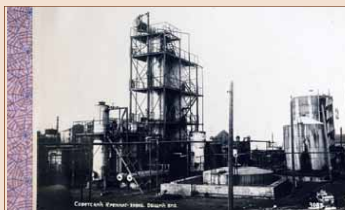
Рис. 8. "Лист № 1 из альбома фотографий "Азнефть XVII-му партсъезду 1934 г.". Крекинг-заводы. Установки термического крекинга", 1933г., серебряно-желатиновый отпечаток, 16,3x22,5 см, КП 14291/1.
