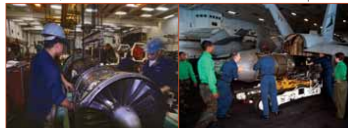
Рисунок 1.61 - а) - ремонтная бригада на борту авианосца Kitty Hawk перед установкой двигателя F404 на истребитель F/A-18. б) - монтаж двигателя
