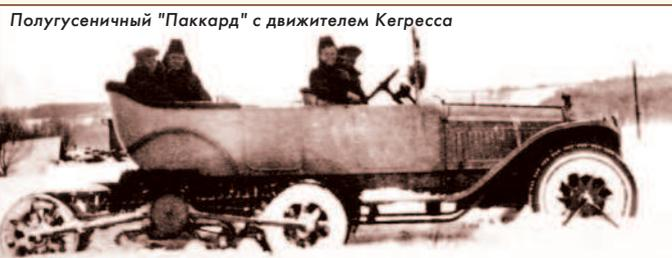
В 1916 г. была предпринята попытка установки движителей Кегресса на бронированные и грузовые автомобили, принимавшие участие в I Мировой войне, и даже был заказ на изготовление 300 экземпляров этих движителей, но революции 17-го года сорвали его выполнение (успели изготовить только 30 комплектов). Поэтому оценить эффективность движителя Кегресса в полной мере тогда не удалось.
