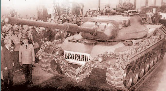
Машина имеет классическую компоновку: справа в передней части корпуса находится место механика-водителя, в башне - в средней части корпуса - установлено основное вооружение танка, там же размещаются остальные три члена экипажа: командир, наводчик и заряжающий. В корме расположено силовое отделение с двигателем и трансмиссией.
