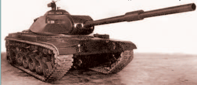
М60 с башней модели "К" и 120-мм пушкой
