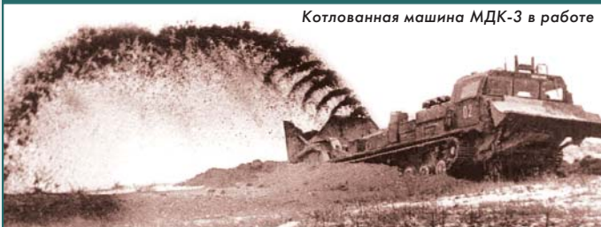
Котлованная машина МДК-3 в работе
