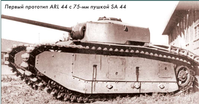
Первый прототип ARL 44 с 75-мм пушкой SA 44
