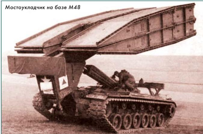
машину приняли в 1958 году. В качестве базы использовались шасси танков М48, М48А1 и М48А2. В конце 1960-х годов бензиновые моторы на мостоукладчиках заменили дизельными.
