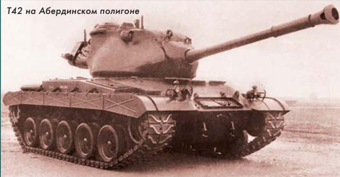
Разработчикам Т42 удалось уложиться в 36 тонн. За основу был взят корпус лёгкого танка Т41 (разрабатывался одновременно с Т42 и тяжёлым танком Т43), поэтому корпус был сравнительно небольшого размера, а ходовая часть содержала по пять катков на борт. Экипаж состоял из четырёх человек - отсутствовал пулемётчик, традиционно сидящий рядом с водителем.
