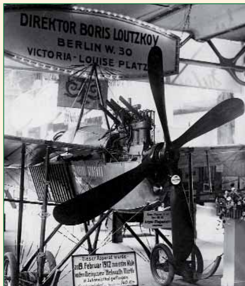
Рис. 6 Самолет с двумя соосно расположенными винтами конструкции Б.Г. Луцкого на авиационной выставке в Берлине, 1912 г.
