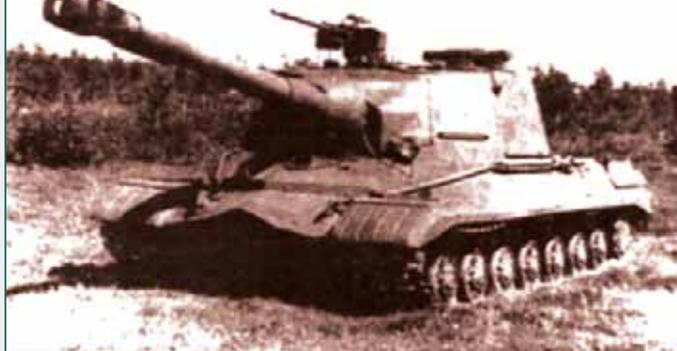
С использованием силовой установки и элементов ходовой части танка Т-10 были спроектированы и более мощные самоходные орудия, способные вести огонь атомными тактическими зарядами. Калибр орудия определяли габариты спецбоеприпасов, у которых на тот момент диаметр составлял более 400 мм. Разработка этих самоходных установок на гусеничном шасси велась с 1954 г.
