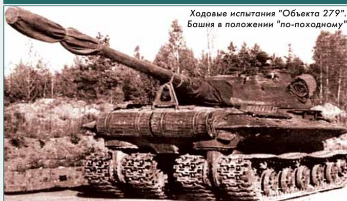
Ходовые испытания "Объекта 279". Башня в положении "по-походному"
