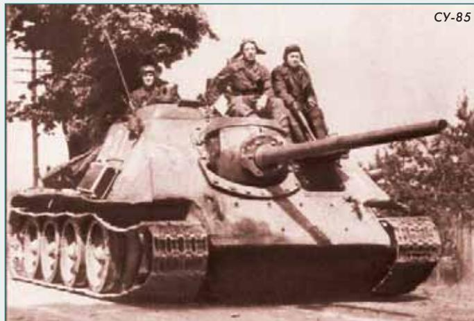
СУ-85 создана на базе среднего танка Т-34 и штурмового орудия СУ-122. Выпускалась на Уральском заводе тяжёлого машиностроения (Уралмаш) с августа 1943 по июль 1944 г., всего было построено 2337 самоходок.
