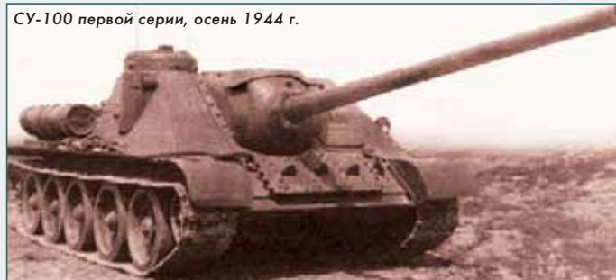
Боевое применения СУ-85 показало, что мощность её орудия недостаточна для эффективной борьбы с «Пантерами» и «Тиграми». Расчёты показывали, что рационален переход к 100-мм калибру. После длительных проработок была создана 100-мм пушка Д-10С, подходящая для установки в корпус СУ-85 без внесения в последний значительных изменений.
