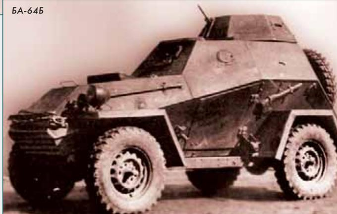
БА-64 - создан в июле - декабре 1941 г. на шасси полноприводного легкового автомобиля ГАЗ-64.
