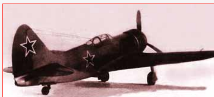
Самолет Ла-7Р-2 с ракетным ускорителем РД-1ХЗ
