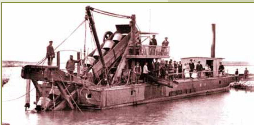
Паровая землечерпалка конца позапрошлого века на очистке Мариинского канала
