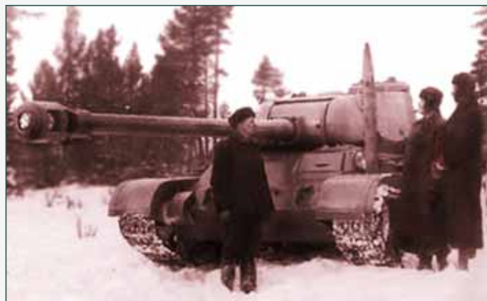
Т-44 с 122-мм пушкой Д-25Т-44 и снарядом к ней.
