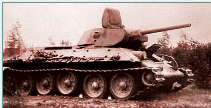
Т-34 образца 1941 г. Эти машины стали вооружаться пушкой Ф-34 (длина ствола 41,3 калибра). Башня сварная. Ширина траков гусеницы была уменьшена с 55 до 50 см и они получили развитую поверхность. В результате улучшились маневренные свойства танка за счет лучшего зацепления гусениц с грунтом
