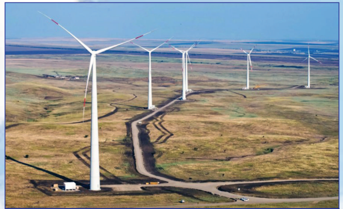
Рис. 11. Кочубеевская ВЭС - крупнейшая в России ветряная электростанция, расположена в Кочубеевском районе. Площадь ветропарка - 75 гектар. Плановая среднегодовая выработка энергии - 597 млн кВт*ч, или 2,18 кВт*ч в сутки на 1 м², что даёт КИУМ 28,7%.
